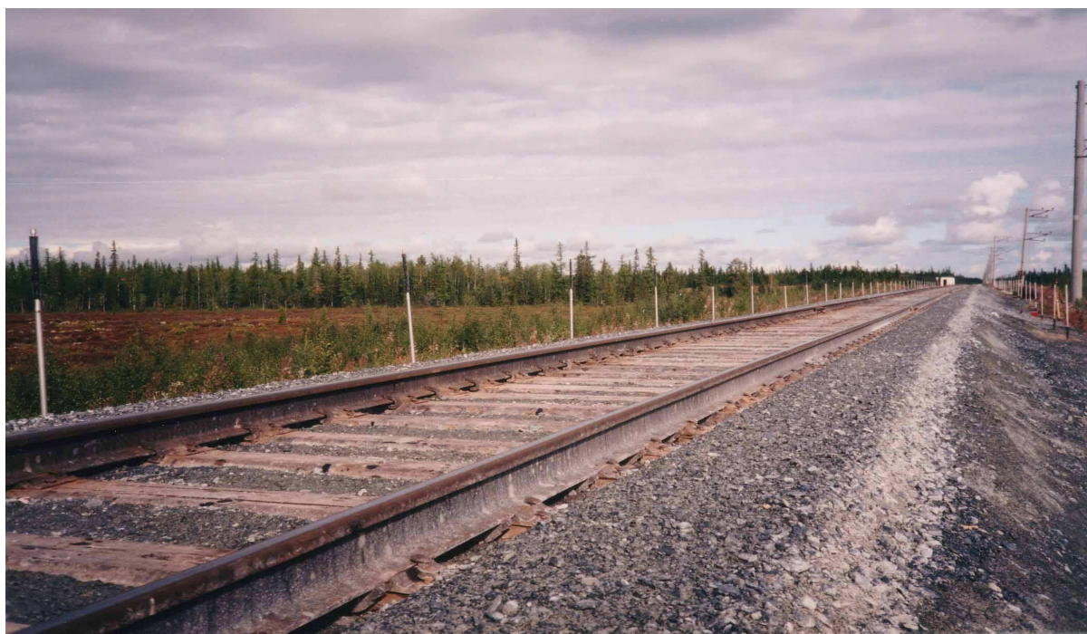
Рис. 1.16 Вертикальные термосифоны (автор Лонг, фото Е.С. Ашпиза)
