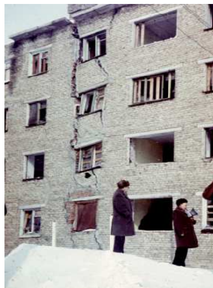
Рис. 1.1 Деформация жилого здания, построенного с использованием грунтов основания по принципу II (фото Е.М. Чувиллина)
