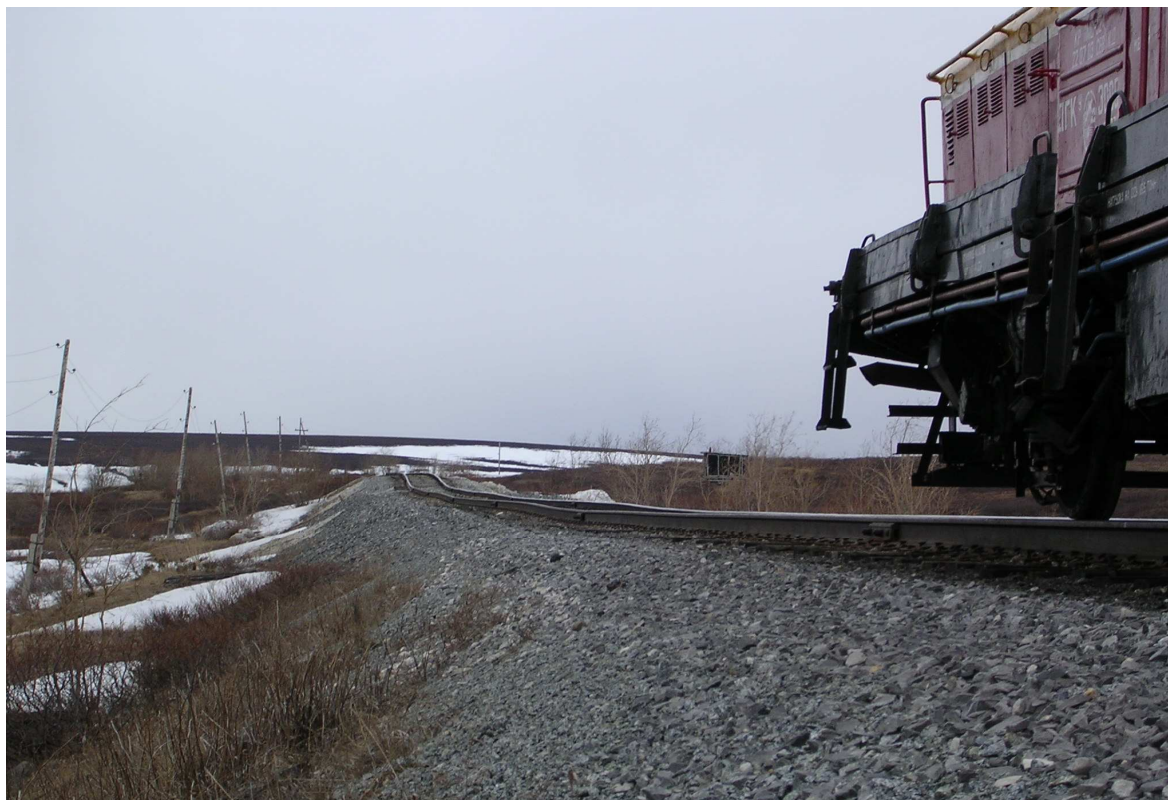
Рис. 1.13 Осадка земляного полотна на 58 км линии Чум – Лабытнанги в результате оттаивания многолетнемерзлых грунтов основания (фото Е.С. Ашпица)
