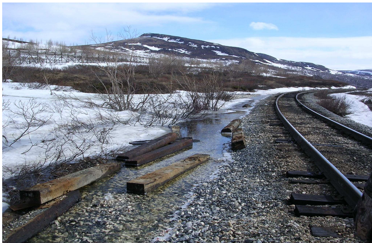
Рис. 1.18 Наледь грунтовых вод (фото Е.С. Ашпиза)
