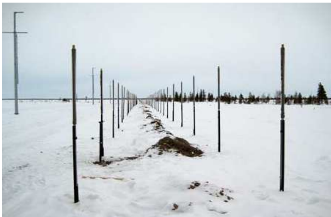
Рис. 1.10 Подземная прокладка нефтепровода Ванкор – Пурпе с охлаждающим контуром из термосифонов (фото С.Н. Окунева)
