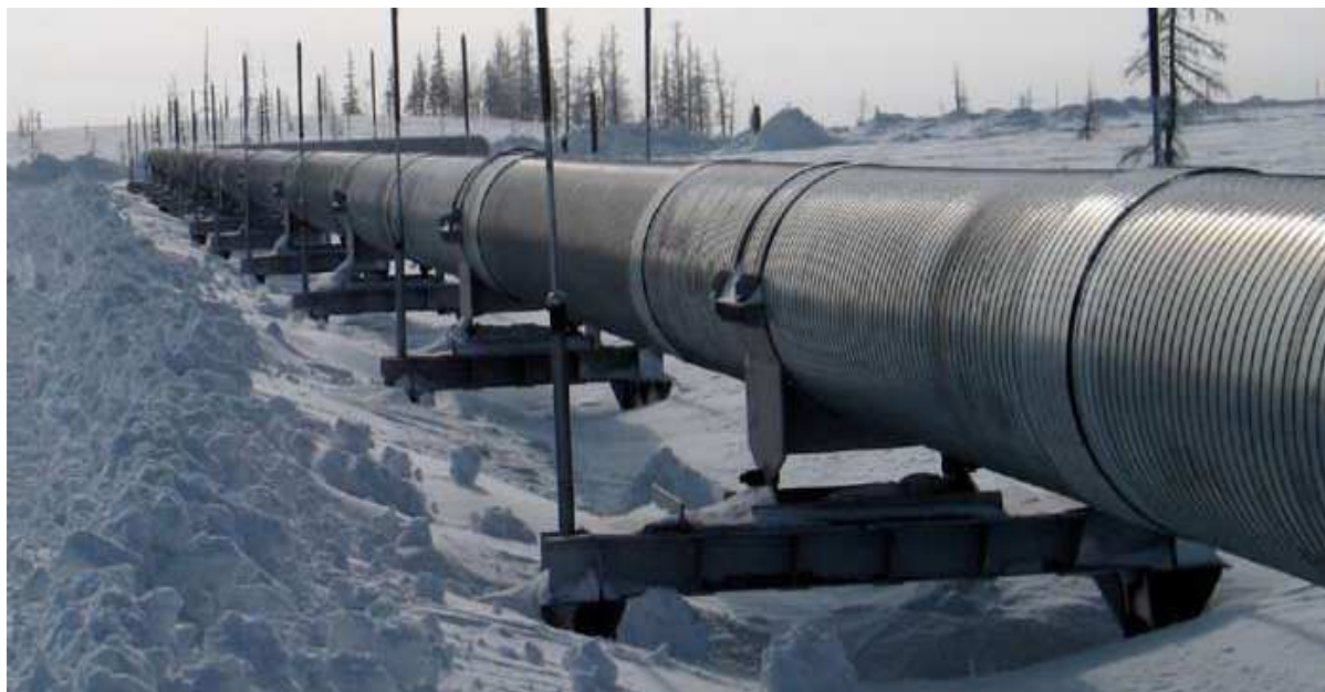
Рис. 1.11 Надземная прокладка нефтепровода Ванкор-Пурпе на низких опорах с термосифонами (фото С.Н. Окунева)
