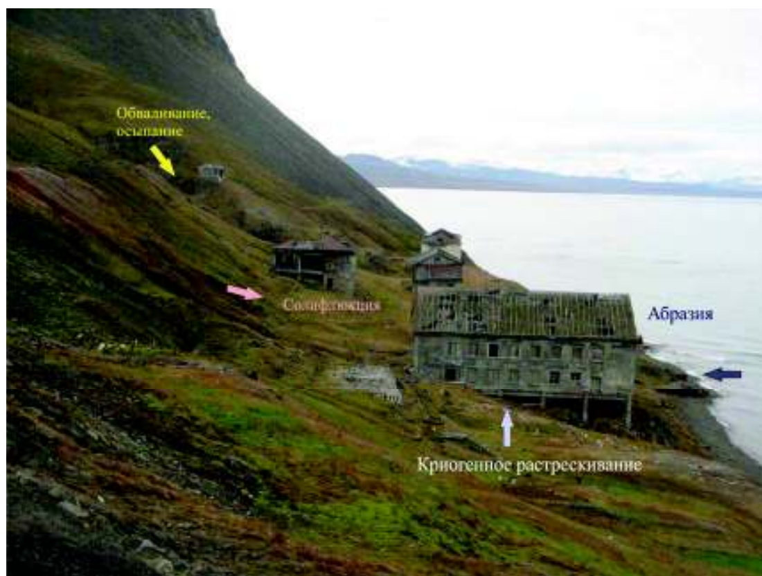
Рис. 3. Геоморфологические процессы, оказывающие деструктивное воздействие на инфраструктуру поселка Грумант. Фото В.В. Шарина, 2011 г
