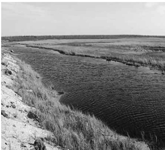
А — подпрудное озеро вдоль трассы газопровода
