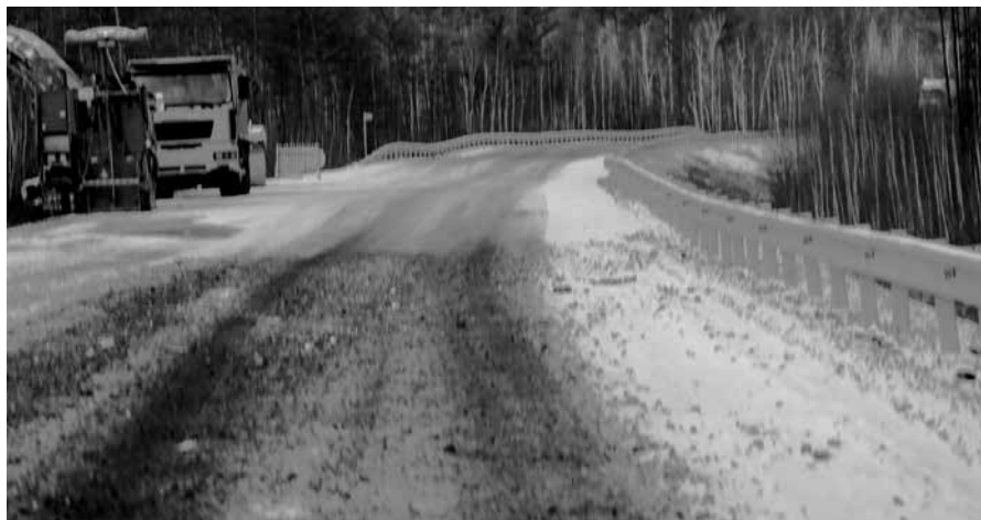
Рис. 4.27. Перманентный ремонт автодороги «Амур» на одном из участков деградации вечной мерзлоты в ее основании, Забайкальская часть дороги, 19 октября 2014 г.
