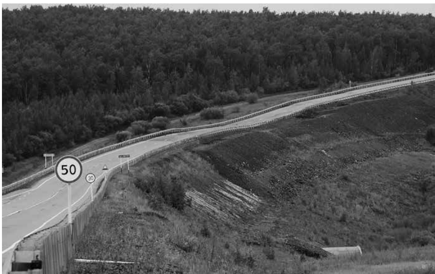
Рис. 4.29. Состояние автодороги «Амур» на переходе через руч. Чичон, 247 км, 16 августа 2013 г.
