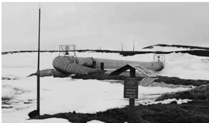
Рис. 8.11. Термометрическая скважина и деформационные марки на трубе на ПК 710
