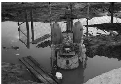
Рис. 4.6. Магистральные газопроводы \varnothing 1420 мм. Различные типы деформаций на участках потери несущей способности мерзлых оснований. а, б — деформации газопровода в плане на участках оттаивания ММП и всплывтия; в — оттаивание ММП под тепловым воздействием подземных газопроводов на участках расположения крановых узлов
