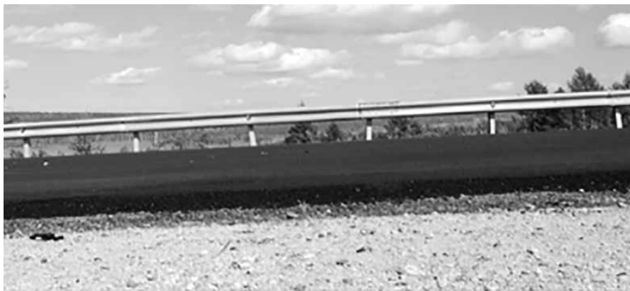
Рис. 4.31. Подсыпка — основной способ устранения просадок автодороги «Амур» на участках деградации вечной мерзлоты в ее основании, 15 августа 2012 г.
