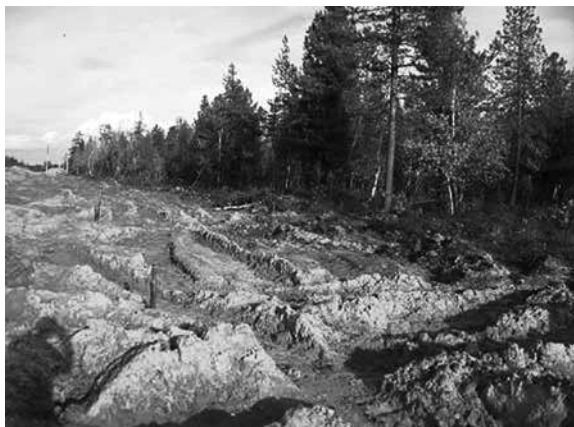
Рис. 4.17. Зона с нарушенным растительным покровом и измененным при перекладке газопровода рельефом вдоль трассы газопровода (2005 г.)
