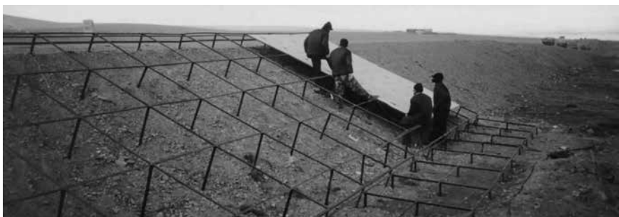
Рис. 4.28. Сооружение солнцезащитного навеса на Цинхай-Тибетском шоссе, сентябрь 2003 г.
