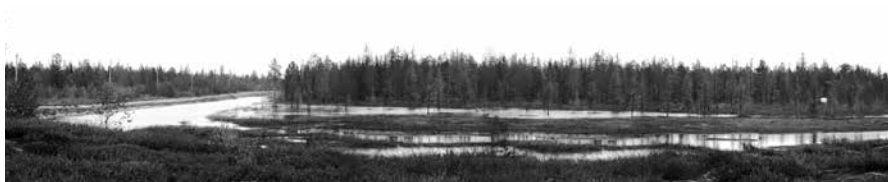
Рис. 4.18. Нарушение естественных условий стока поверхностных вод в 2005 г., в ходе реконструкции газопровода Надым—Пунга привело к временному подтоплению территории на 8 км трассы газопровода Надым—Пунга
