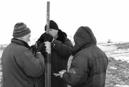
Рис. 8.10. Монтаж оголовка скважины
