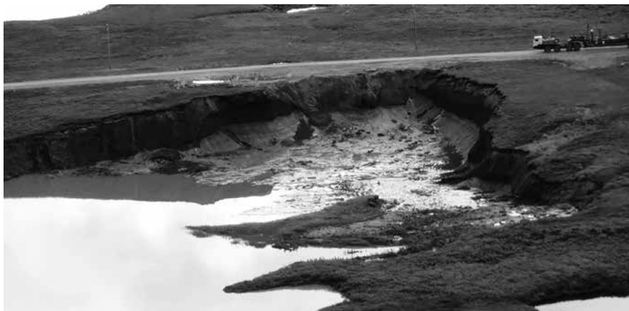
Рис. 4.15. Бованенковское нефтегазоконденсатное месторождение. Термоденудационная просадка в опасной близости от внутрипромысловой автомобильной дороги
