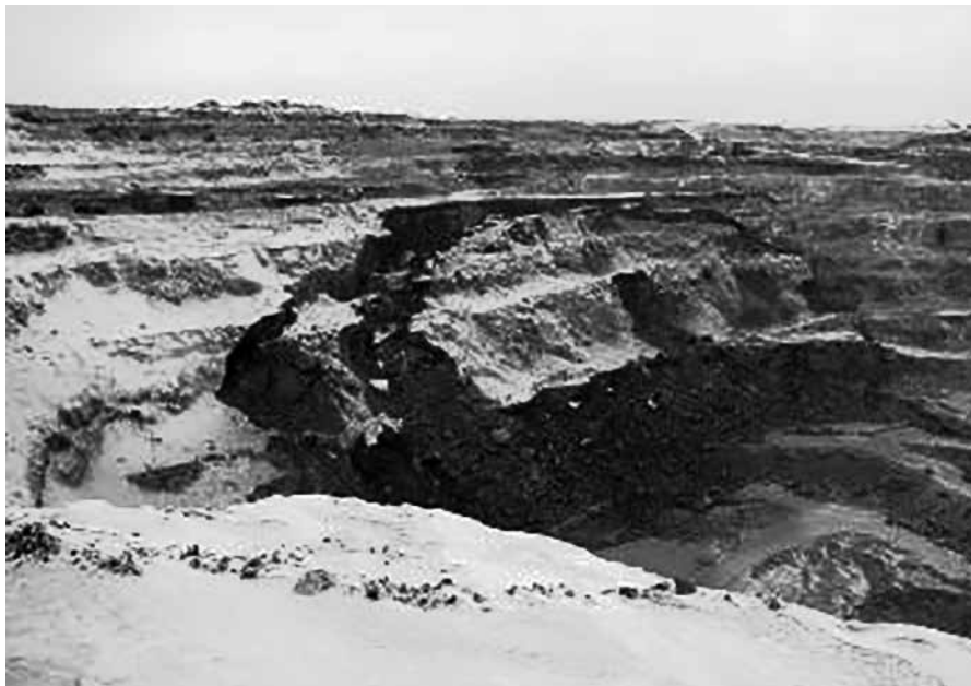
Рис. 4.32. Обрушение участка борта карьера в мерзлых породах
