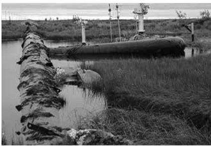
Рис. 4.6. Магистральные газопроводы \varnothing 1420 мм. Различные типы деформаций на участках потери несущей способности мерзлых оснований. а, б — деформации газопровода в плане на участках оттаивания ММП и всплывтия; в — оттаивание ММП под тепловым воздействием подземных газопроводов на участках расположения крановых узлов
