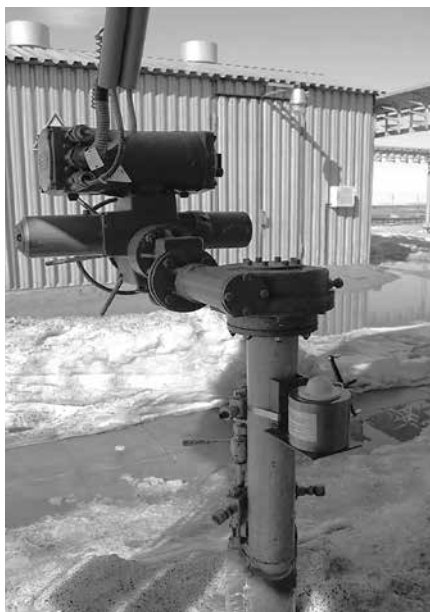
Рис. 8.14. Деформационные марки на КУ 159 на КС «Байдарацкая»
