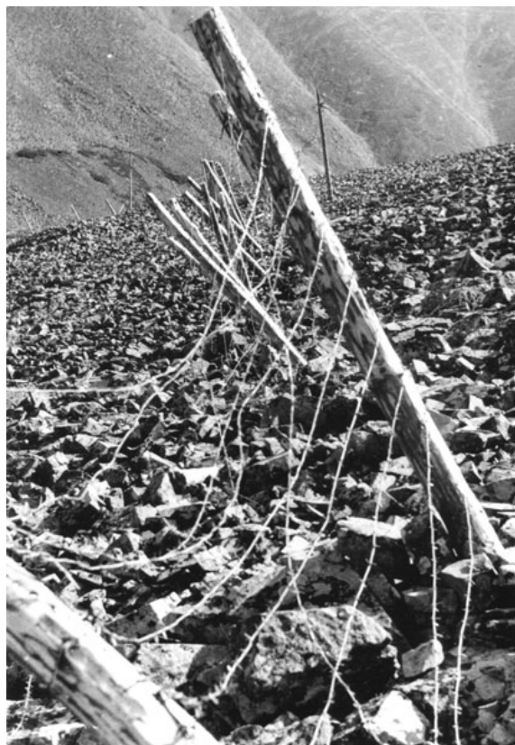
Фото 10.24 Деформация ограждения на курумном склоне. Хребет Удокан
