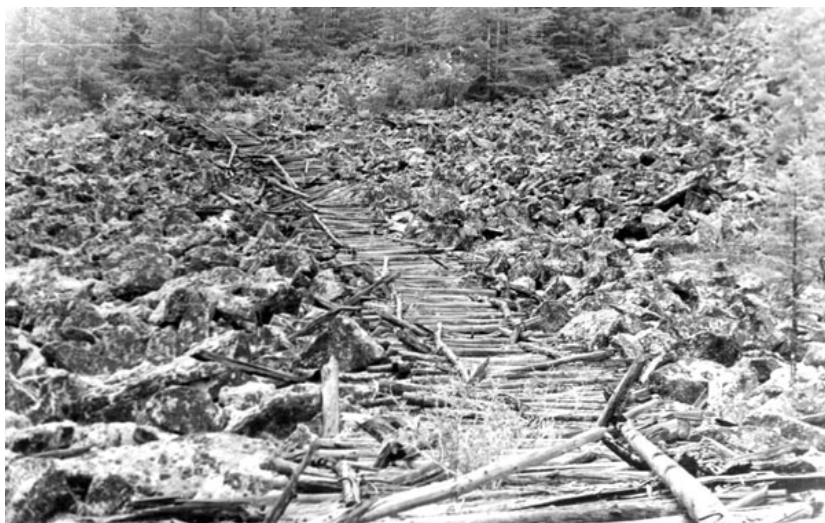
Фото 10.25. Разрушение лежневой дороги, предназначенной для прогона оленей через курум. Правый берег реки Витим
