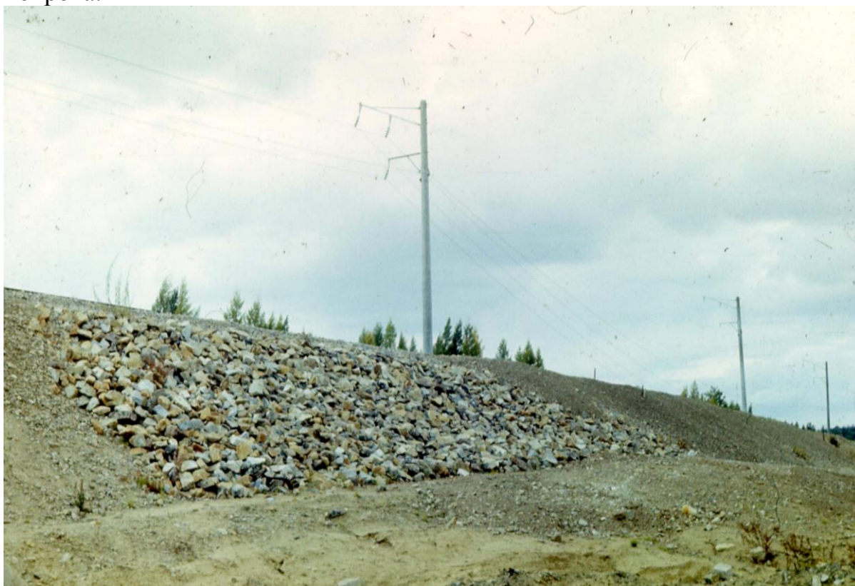
Рис. 1.15 Каменная наброска на откос на одном из участков БАМ (автор Г.П. Минайлов, фото Г.П. Минайлова)
