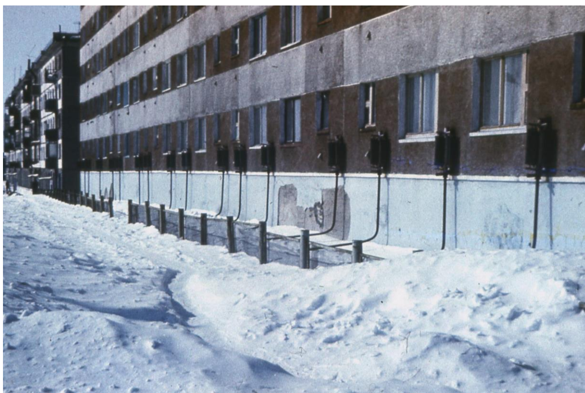
Рис. 7.4 Охлаждающий контур на одном из деформирующихся зданий в Воркуте (Фото Л.Н. Хрусталева)
