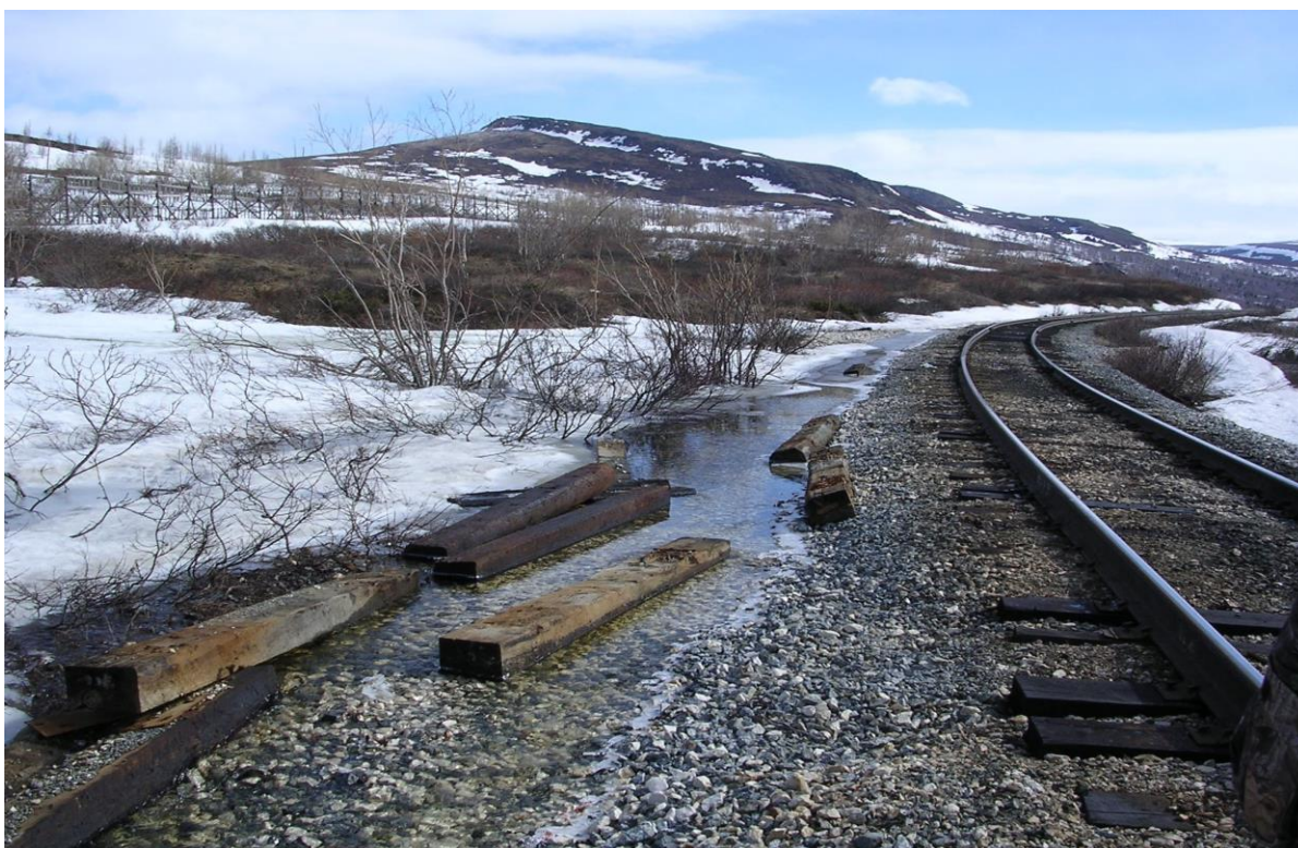
Рис. 1.18 Наледь грунтовых вод (фото Е.С. Ашпиза)
