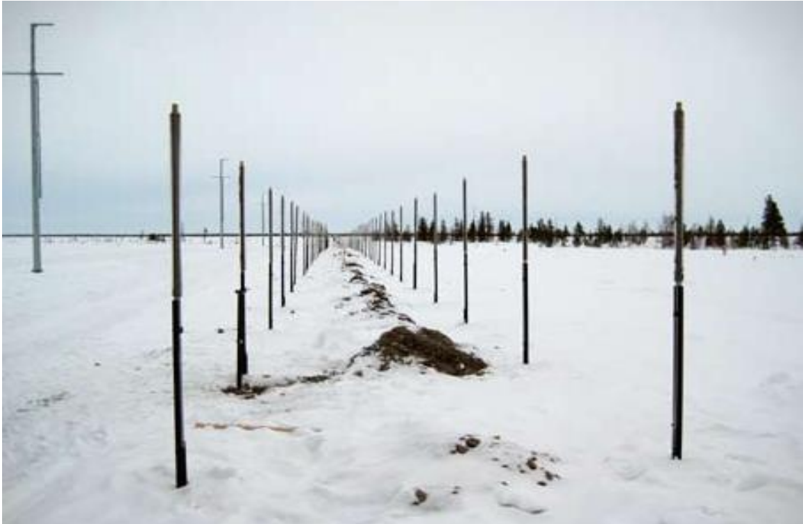
Рис. 1.10 Подземная прокладка нефтепровода Ванкор – Пурпе с охлаждающим контуром из термосифонов (фото С.Н. Окунева)
