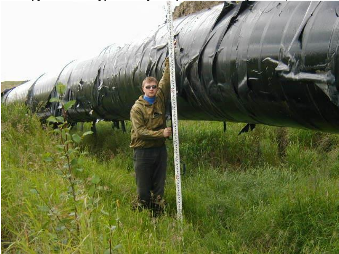
Рис. 1.9 Вытучивание подземного газопровод (фото В.В. Лашина)
