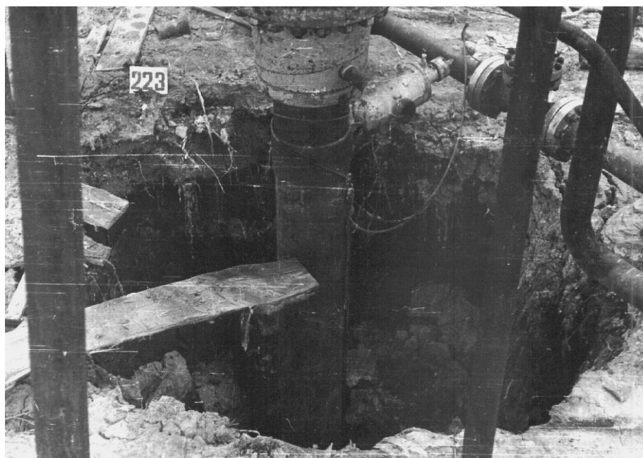
Рис. 1.20 Термокарстовая воронка вокруг газодобывающей скважины на Медвежьем газоконденсатном месторождении (Фото Л.Н. Решетникова)
