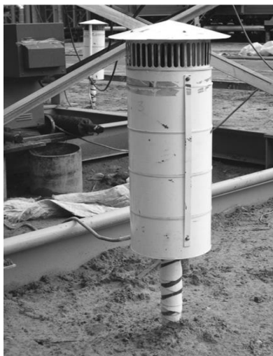
Рис. 2.7 Противоточный термосифон с электрической насадкой на конденсаторе (фото М.А. Минкина)
