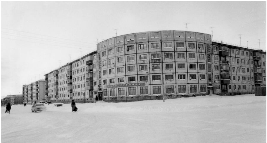
Рис. 3.9 Панорама микрорайона Б пос. Воргашор (Воркутинский район). Устойчивость зданий микрорайона обеспечивается стабилизацией верхней границы ММГ с помощью вентилированного подполья.
