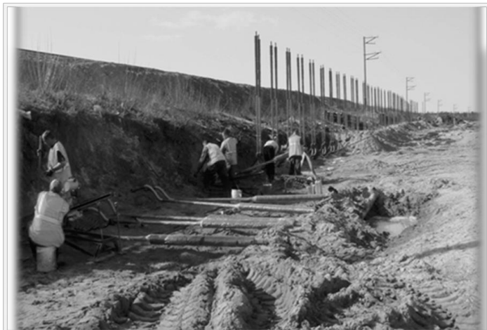
Рис. 3.7 Рабочий момент установки охлаждающего контура
