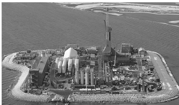
Рис. 5.1 Стальная буровая платформа (вверху) и грунтовый остров (внизу). Фото неизвестного автора.
