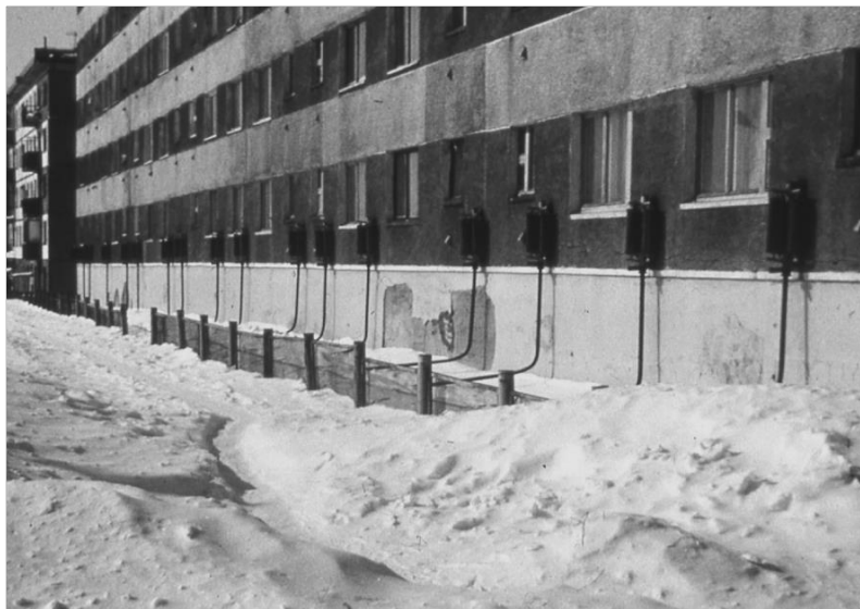
Рис. 3.3 Здание общежития в пос. Ворга-Шор (Воркутинский р-н), построенное с охлаждающим контуром
