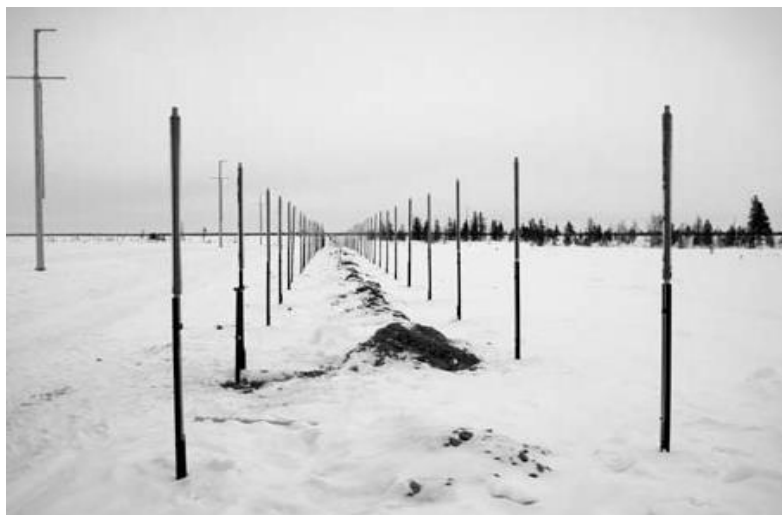
Рис. 3.5 Подземная прокладка нефтепровода Ванкор – Пурпе с охлаждающим контуром из термосифонов (фото С.Н. Окунева)
