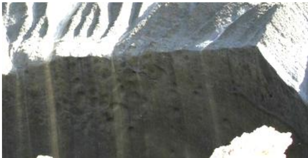
Рис. 4.63. Каверны на поверхности свода над газонасыщенной зоной (фрагмент рис. 4.62.)
