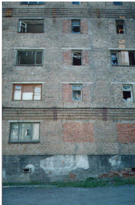
Рис. 9. Слева - расселенный дом в аварийном состоянии, подлежащий сносу. Ул. Варгашор, 14, Воркута. Справа - фрагмент дома по ул. Лермонтова, 13 в Воркуте после проведения ремонтно-восстановительных работ. Часть оконных проемов была заложена кирпичной кладкой, видны два пояса укрепляющих стальных стяжек над первым и четвертым этажами. (Фото Н.Б. Кокунова)
