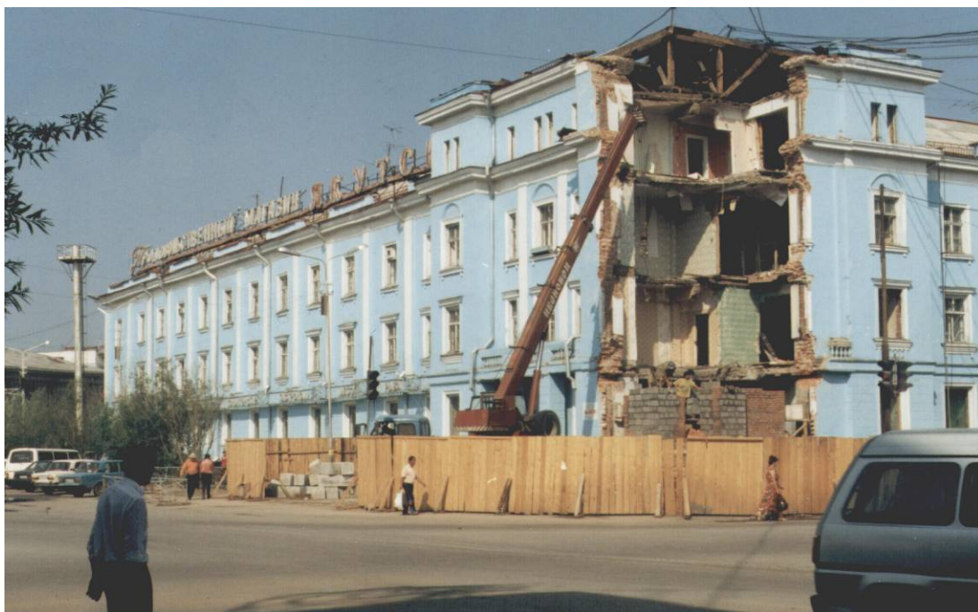
Рис. 12. Обрушение угла здания в центральной части г. Якутска, 1999 г. (Фото М.Н. Григорьева) (Алексеева и др., 2007).
