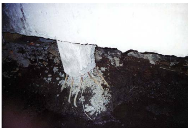
Рис. 15. Жилой дом в аварийном состоянии в Дудинке. Обследование выявило, что причиной просадки стало эрозионное разрушение железобетонных свай основания. Фото В.Гребенец.
