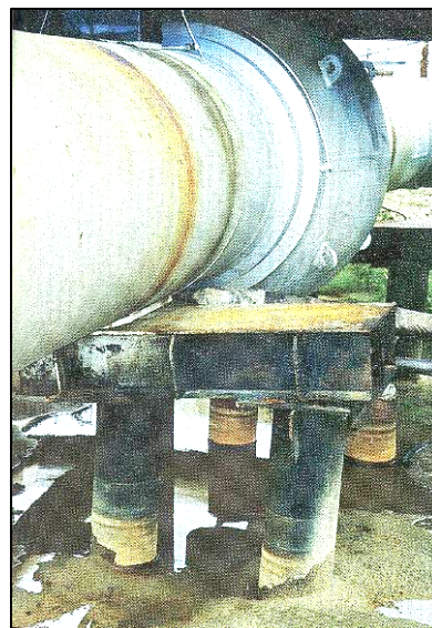
Рис. 24. Слева - устройство опор транс-Аляскинского трубопровода в применении термосифонов. Фото Н.И. Шикломанова. Справа – деформация опоры трубопровода в Западной Сибири. Фото из (Гарагуля, Ершов, 2000)
