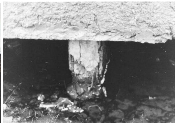
Рис. 15. Жилой дом в аварийном состоянии в Дудинке. Обследование выявило, что причиной просадки стало эрозионное разрушение железобетонных свай основания. Фото В.Гребенец.
