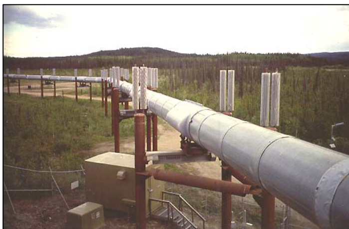
Рис. 24. Слева - устройство опор транс-Аляскинского трубопровода в применении термосифонов. Фото Н.И. Шикломанова. Справа – деформация опоры трубопровода в Западной Сибири. Фото из (Гарагуля, Ершов, 2000)
