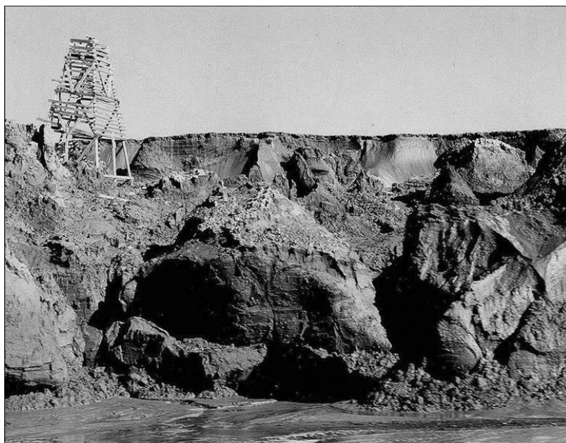
Рис. 7. Навигационный знак «Ванькин», вертикально сползший вниз и впоследствии разрушенный. Южный берег острова Большой Ляховский, Восточно-Сибирское море. Фото М. Григорьева.
