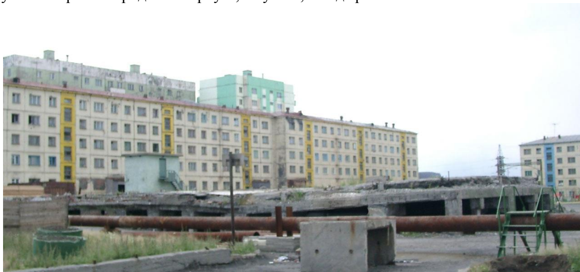
Рис.9. Аварии гражданских зданий. Норильск, на переднем плане деформированный криогенными процессами фундамент разобранного 5-этажного панельного здания, 2006 г. (фото Д.С.Дроздова)
