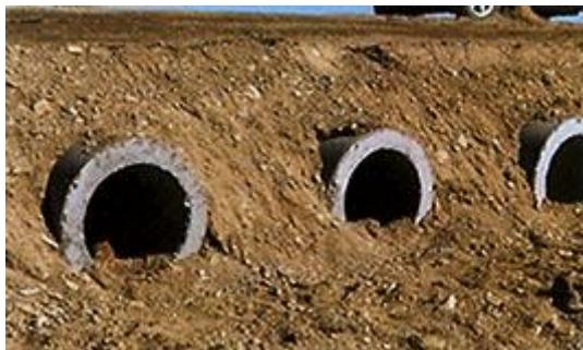
**Рис. 2. Вентиляционные трубы в теле насыпи**
