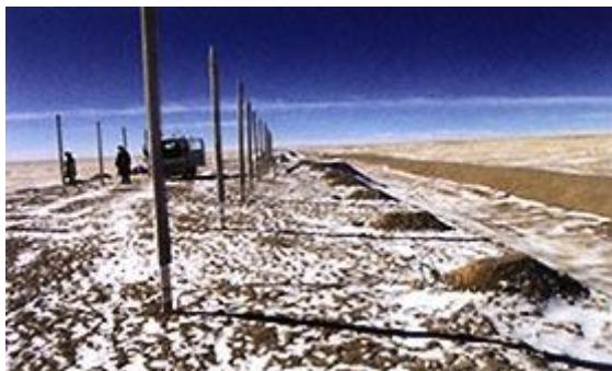
**Рис. 3. Тепловые стержни, установленные в основание пути перед сооружением насыпи**
