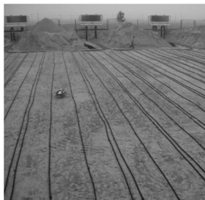
Рис. 2. Горизонтальная естественнодействующая парожидкостная трубчатая охлаждающая система с единым конденсаторным блоком (фото Окунева С.Н.)
